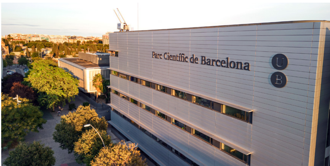
Panoràmica de l'edifici Clúster II
