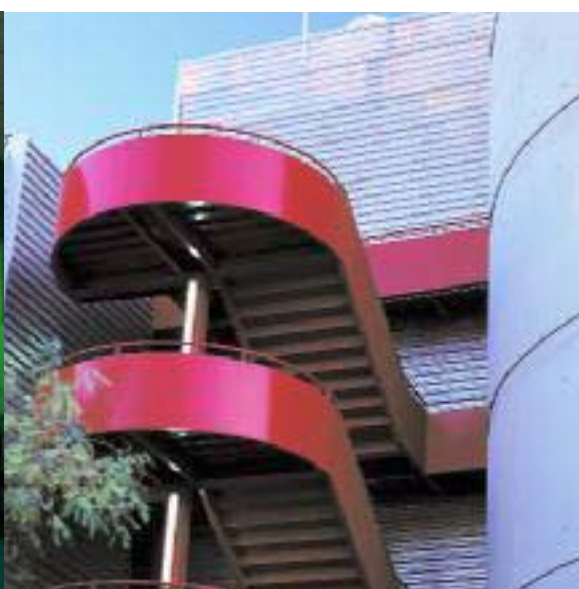
Edifici Torre D Edificio Torre D
